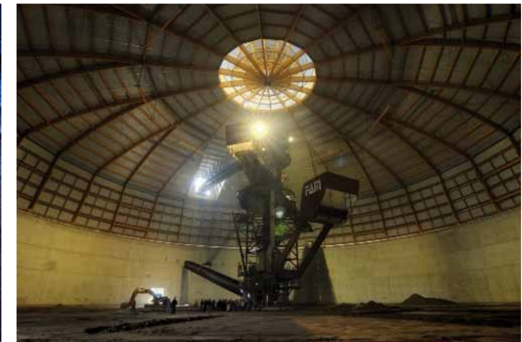
Im geschlossenen Kohlelager erfolgt das Ein- und Auslagern der Kohle automatisch.
